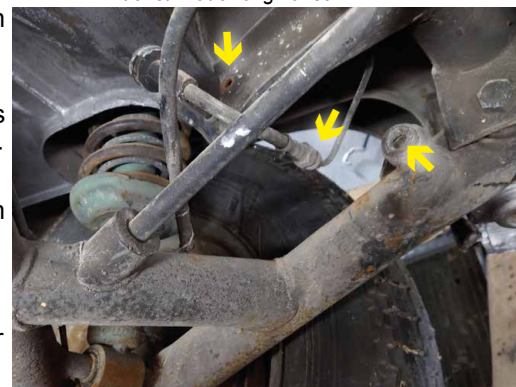
Hier hätte ein Bremskraftregler sitzen müssen... das wird demnächst wieder original sein!
