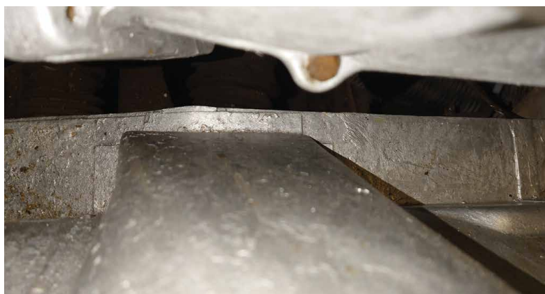
Der Federbeindom senkrecht von oben... an dieser Stelle mündet er direkt über eine Öffnung in den Längsträger
