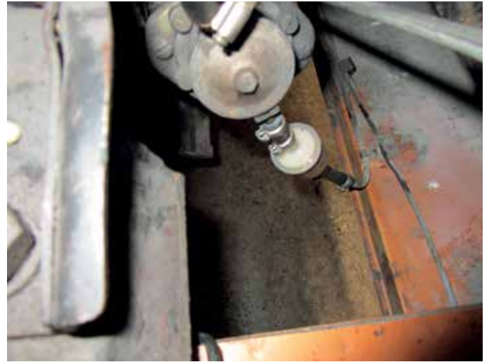
15. Benzinleitung beim 71er im Frontblech, Zulauf an die Saugleitung anschließen.
