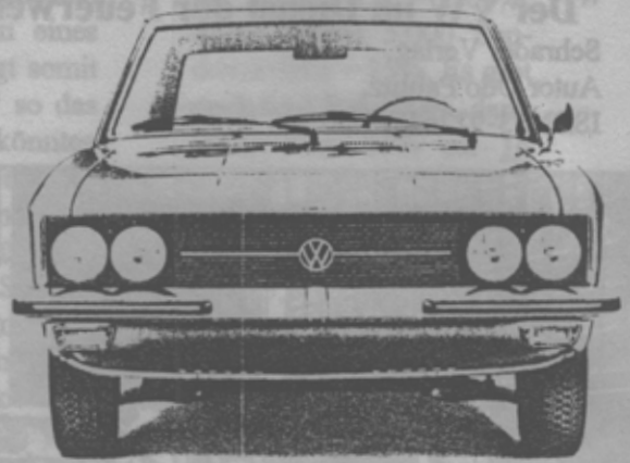
Der VW K 70, der ursprünglich NSU K 70 heißen sollte, bricht mit den Traditionen von VW: Er hat einen Frontmotor und Wasserkühlung.
